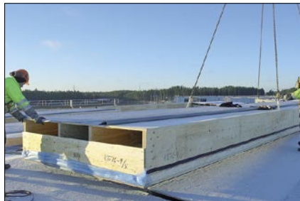
Kerto-Ripa -kattoelementin asennus Ikean Raison työmaalla
