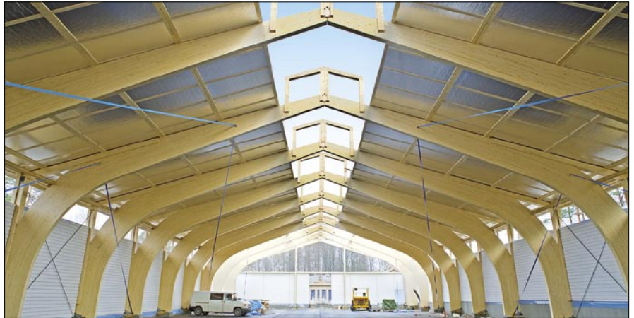
Espoolainen ratsastusmaneesi katettiin Kerto-runkoisin kattoelementein
