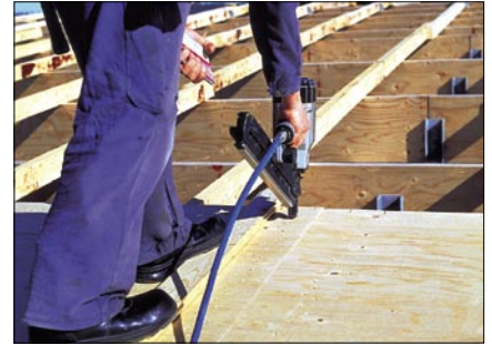
Spruce-havuvanerin asennusta rakennustyömaalla
