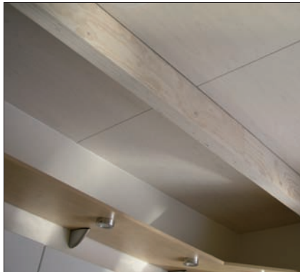
Kertopuut jätetty vanerikatossa näkyviin sisustuselementtinä
