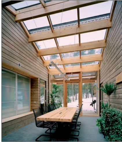
Talo Kekkapää. Liimapuuta käytetty innovatiivisesti rakenteissa, osana sisustusta. Kuva: Antti Hahl
