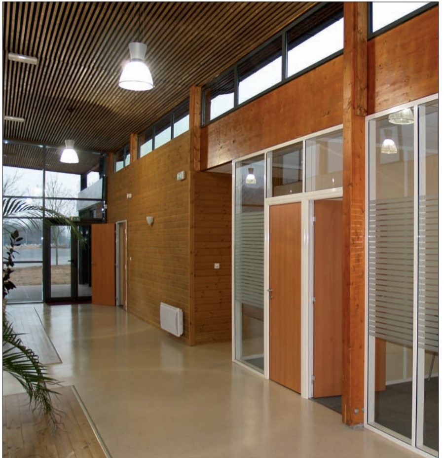
Lämpöpuinen säleikkökatto ja tehosteseinä
