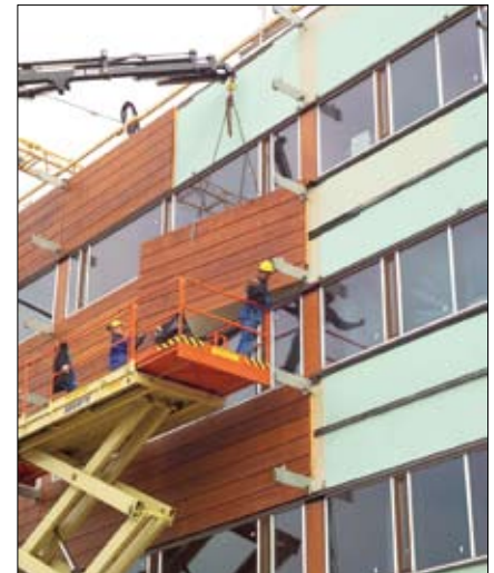
Kuningaspaneelin elementtikiinnitys, FMO Tapiola, Espoo
